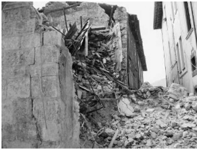
図9 泥で固めた組積造
