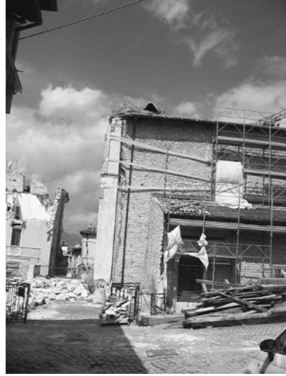
図14 ファサードをベルトで止めた教会
