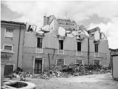
図5 崩壊した歴史的建築物
