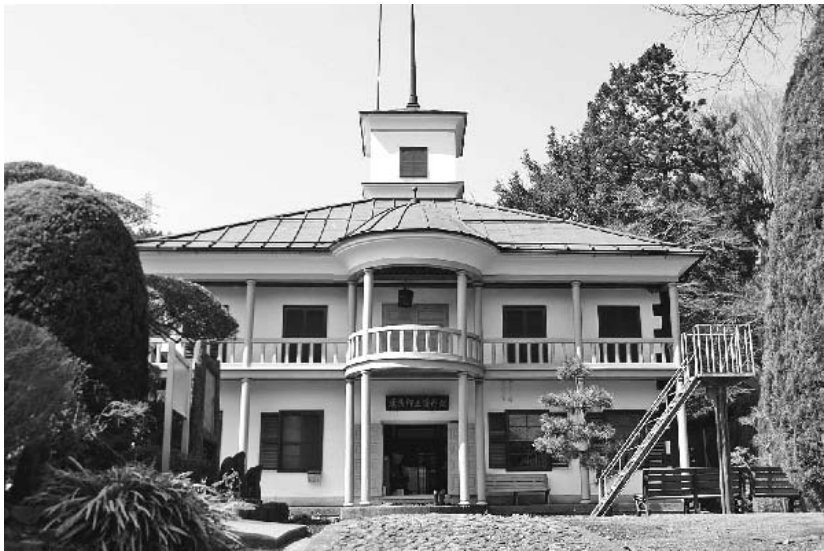
図1 現在の尾県学校（尾県郷土資料館）の外観
