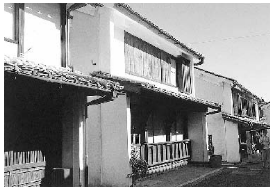
写真11 内子町並み保存地区内の修理された民家 (2005年8月)
