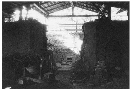
写真1 南部川村嶋之瀬における備長炭窯の構築 (2004年3月) 瓦と粘土で構築、備長炭新規参入者(55歳)の窯
